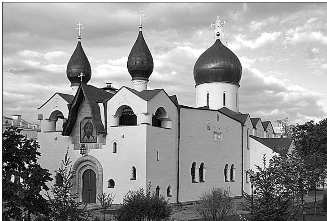
Церковь Покрова Марфо-Мариинской обители. Архитектор А.В.Щусев. Закладка состоялась в 1908, освящение — в 1912.
